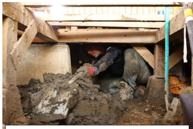
床下の泥出しは狭い場所での苦しい作業ですから、大勢で交代しての活動が必要です。
