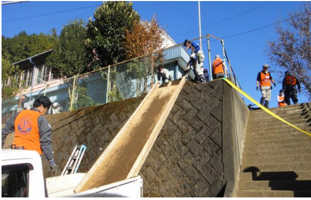
すべり板を渡すことでアップした作業効率
