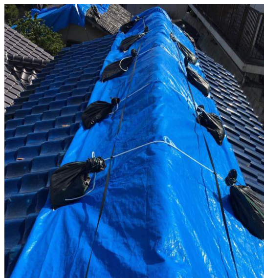
屋根の応急修理（大阪北部地震）保険が出れば 台風21号で飛ばされてしまったケースが多発
