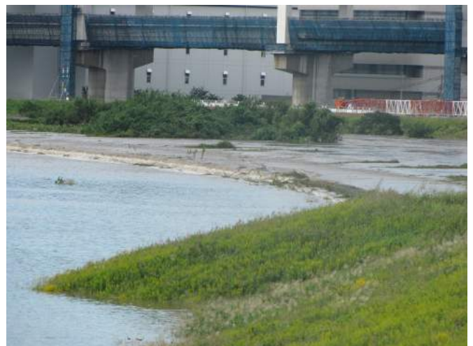
新羽地区の一部の堤防が低く設定されており、そこからあえて水を溢れさせて遊水池に導き洪水を防ぐ
